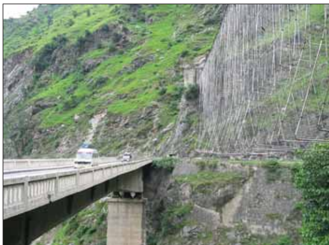
Obr. 2 Portálový svah budoucích tunelů v km 166; vpravo síť chránící most před padajícími kamenům
