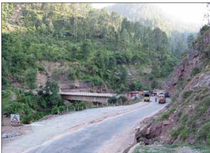
Obr. 2 Severní portál tunelu Fig. 2 Northern tunnel portal
