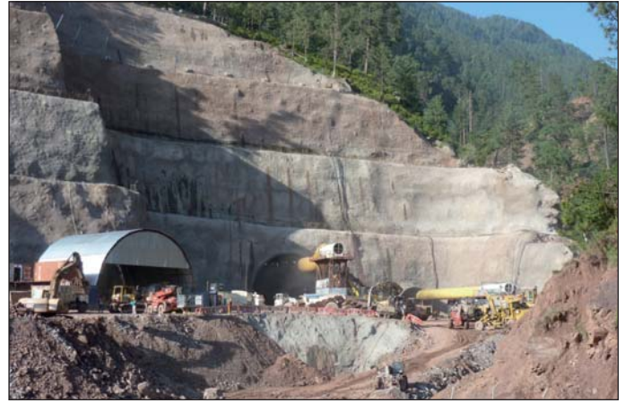
Obr. 4 Severní portál tunelu Patnitop (Chenani – Nashri) pod průsmykem Patnitop (2012)
