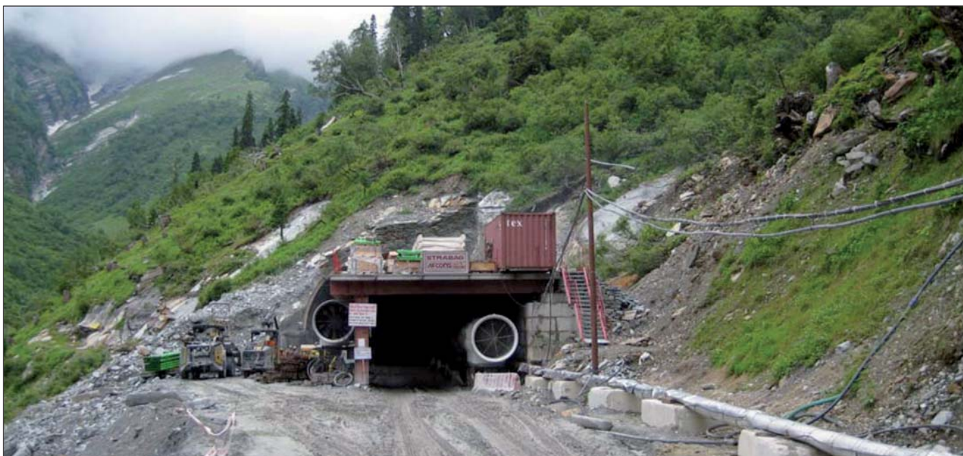
Obr. 8 Jižní portál tunelu Rothang
