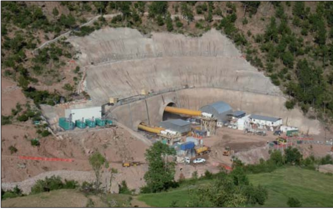
Obr. 3 Jižní portál tunelu Patnitop (Chenani – Nashri) pod průsmykem Patnitop (2012)
