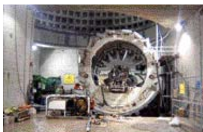
Obr. 5 – Tunelovací štít pro HEXEx před zahájením ražby
