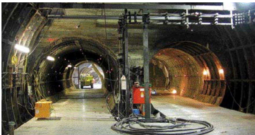
Obr. 9 – Napojování nových tunelů na trasu Piccadilly
