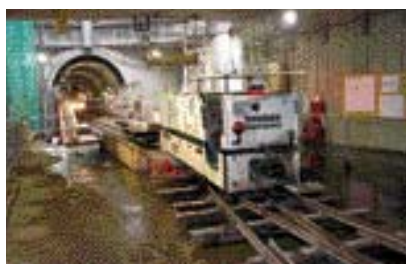
Obr. 4 – Úzkokolejná železnice pro dopravu betonových dílců
