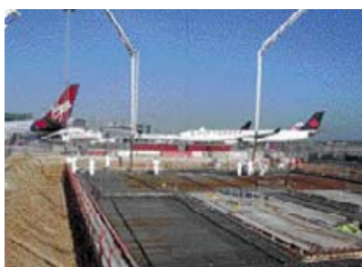
Obr. 2 – Realizace hloubené napojení nových tunelů na trasu Piccadilly
