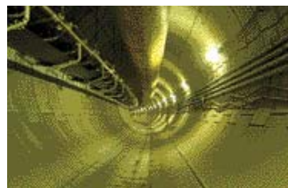
Obr. 6 – Tunel HEXEx během ražeb
