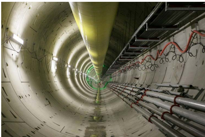
Obrázek 13. Segmentové ostění trat'ového tunelu trasy A pražského metra
