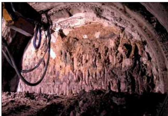
Obr. 7 Účinek tryskové injektáže v první sekci zmáhání závalu (foto P. Svoboda)
