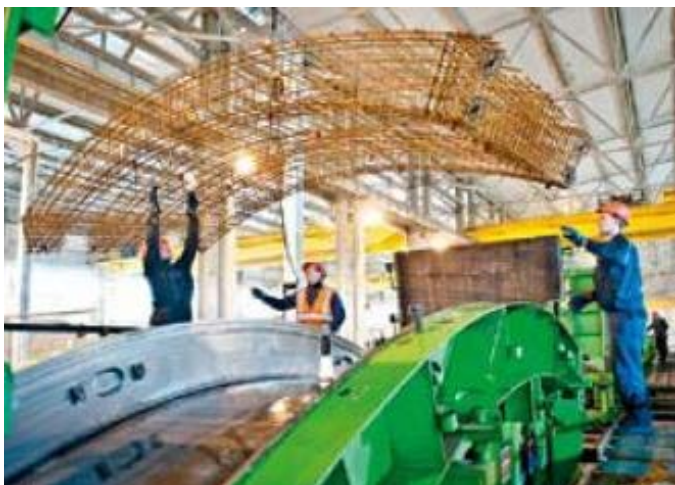
Obrázek 7. Ocelové armokoše umísťované do forem při výrobě železobetonových segmentů
