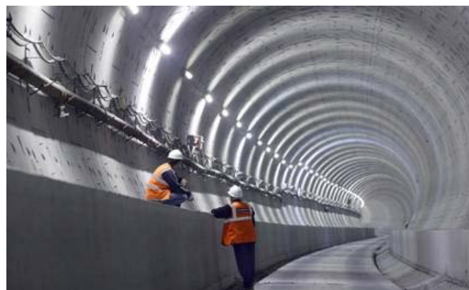
Obrázek 10. Tunel CTRL s drátkobetonovými segmenty
