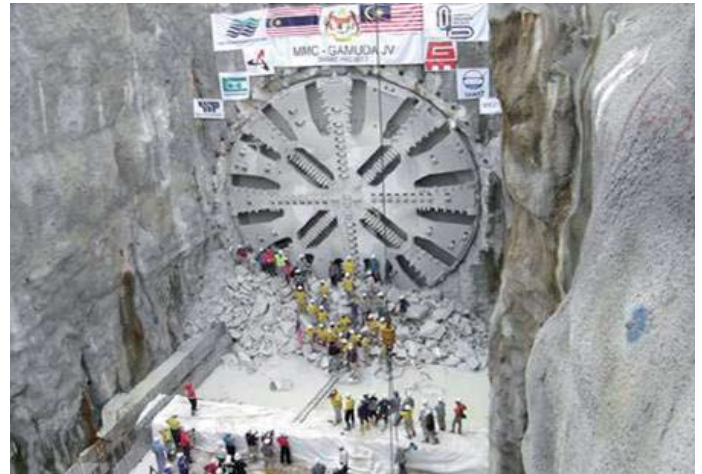
▲ Obr. 7 prorážka do jižní hloubené křižovatky
