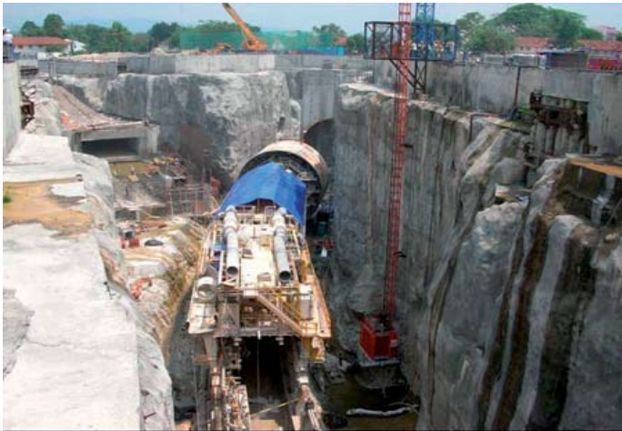
▲ Obr. 6 TBM v severní hloubené křižovatce
