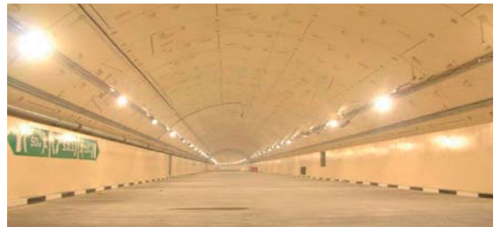
▲ Obr. 8 pohled do horního patra tunelu před dokončením
