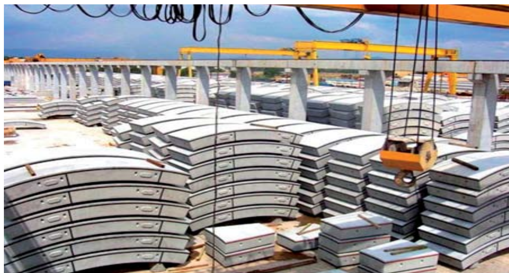
▲ Obr. 5 prefabrikované dílce železobetonového ostění
