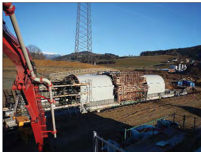
Obr. 15 Betonáž bloků přesypného tunelu
