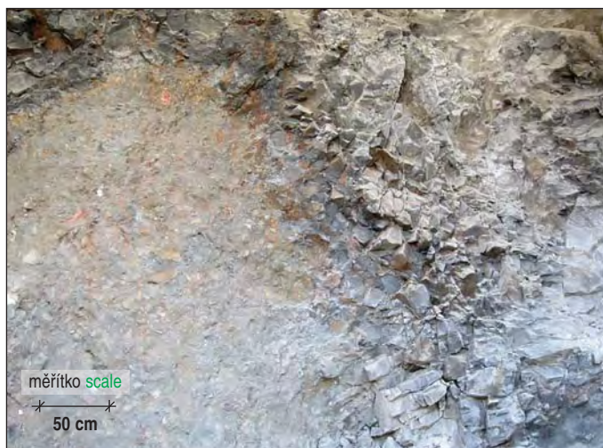
Obr. 4 Detail kontaktu čediče s tepelně zpevněnými slepenci, tunel DG1 Fig. 4 A detail of the contact of basalt with thermally solidified conglomerates, tunnel DG1
