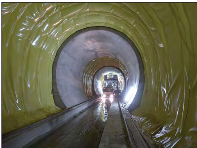
Obr. 12 Betonáže definitivního ostění Fig. 12 Final lining concrete casting
