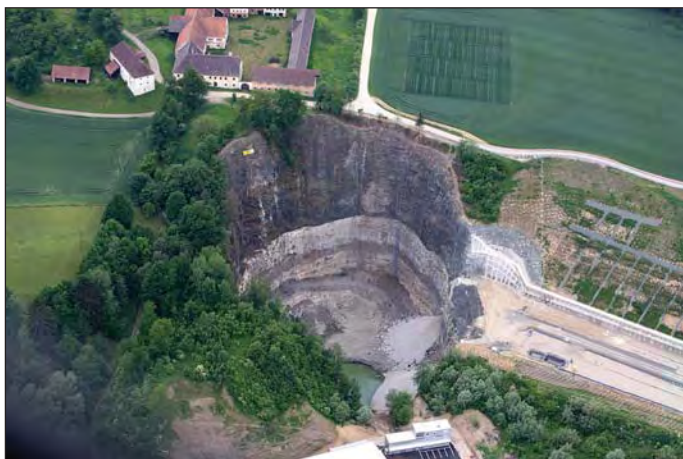
Obr. 3 Pohled na vytěžený bazaltový sopečný komín, budoucí severní portál tunelů DG, světlé stěny ohraničují původně zatopenou část
