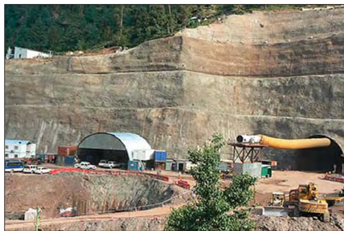
Obr. 8 Portál tunelu Z-Morh Fig. 8 Z-Morh tunnel portal
