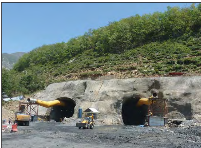
Obr. 5 Silniční tunel Pir Panjal, jižní portál Fig. 5 Pir Panjal road tunnel, South portal
