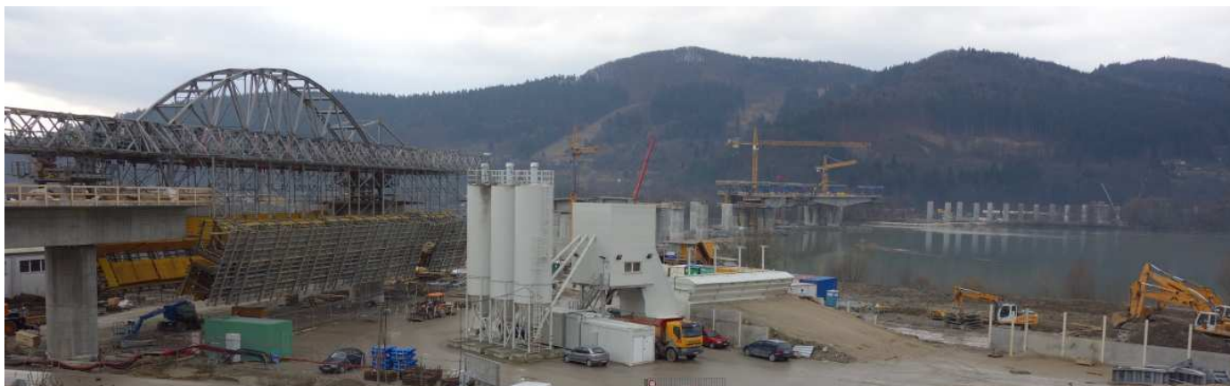
Obrázek 2: Výstavba mostní estakády přes vodní nádrž Hričov na řece Váh
