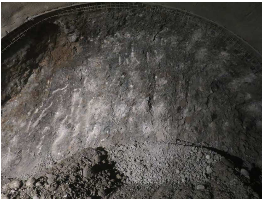
Obrázek 3: Čelba tunelu s exotickými slepenci s jílovito-písčitým tmelem
