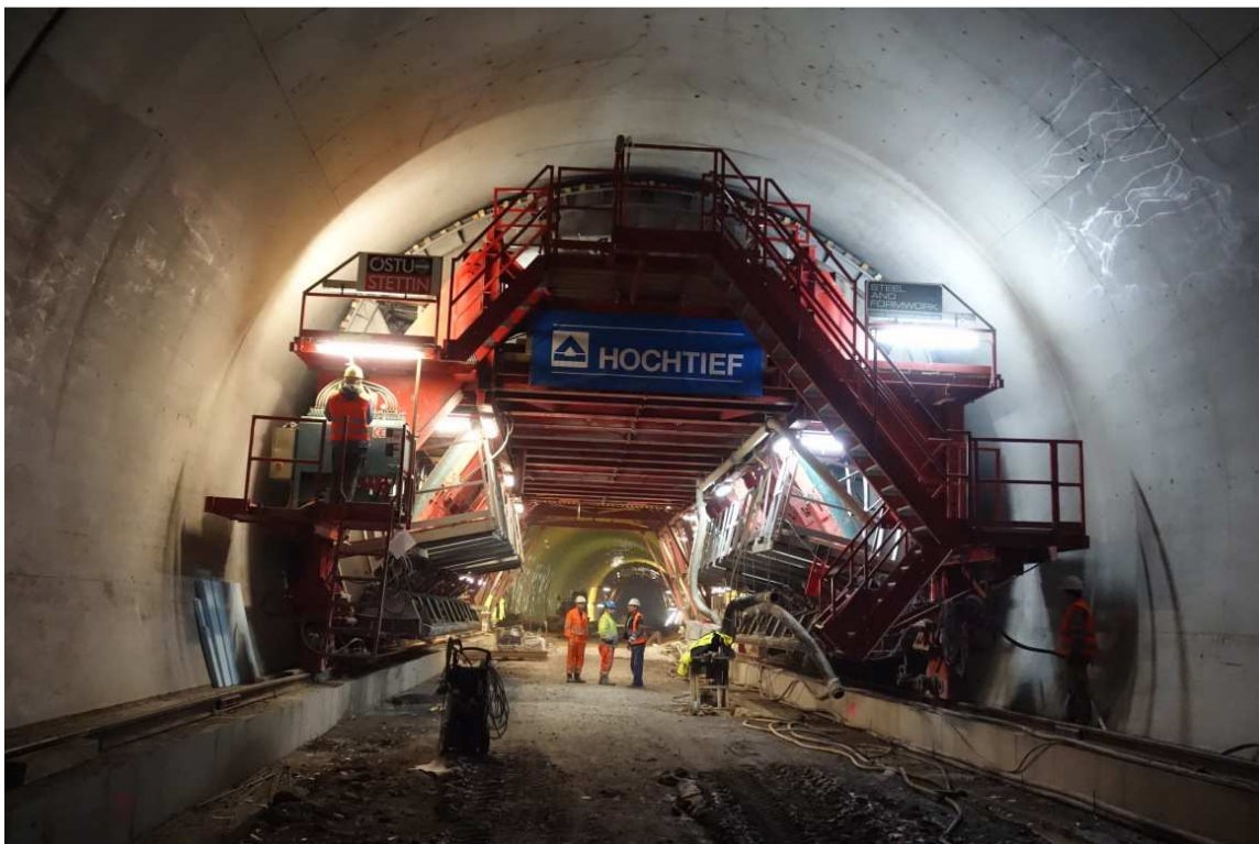
Obrázek 7: Práce na definitivním ostění
