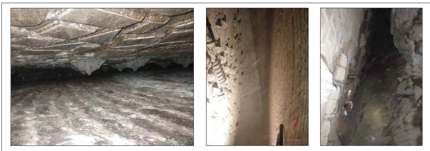
Obr. 8 Příklady dokumentace čelby: a) pohled z „Mannlochu“ vzhůru na stabilní čelbu s otisky řezných disků, b) stabilní, kompletně přístupná čelba v období údržby stroje, c) výrazně blokovitě vylomená čelba dokumentovaná z „Mannlochu“
