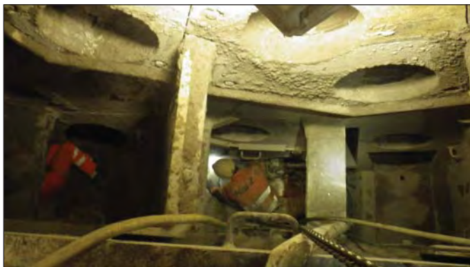
Obr. 7 Provádění inženýrskogeologické dokumentace čelby ze dna razicí komory skrze průřezy v řezné hlavě štítu
