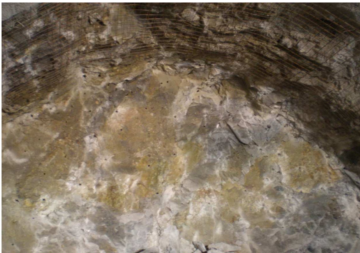
Obr.6 Čelba v prostředí exotických slepenců zajištěná jednou vrstvou sítí bez rámu (foto Hilar) Fig.6 Tunnel face in agglomerate supported by one layer of meshes without frame (photo Hilar)
