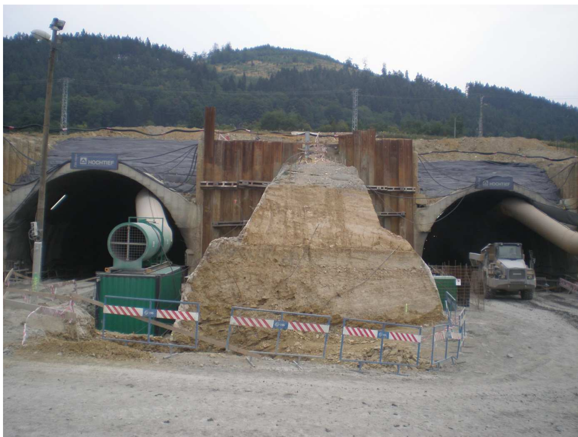
Obr.5 Pohled na západní portál s úseky realizovanými metodou „želva“ (foto Hilar) Fig.5 View on the West portal with section constructed by the „turtle“ method (photo Hilar)
