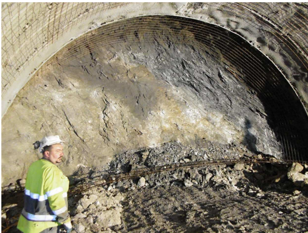
Obr.4 Čelba na kontaktu jílovců a slínovců (vpravo nahoře) se slepenci (vlevo dole) (foto Zmítko) Fig.4 Tunnel face including contact of claystones and siltstones with agglomerate (photo Zmítko)
