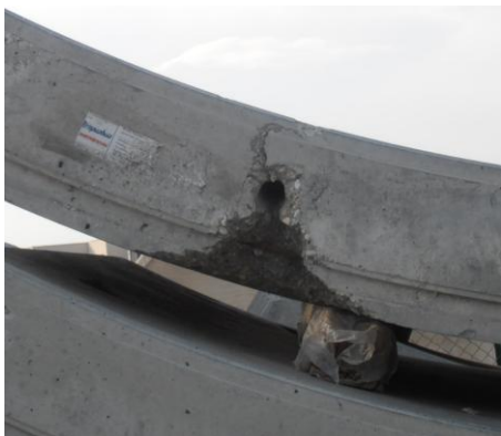
Obr. 5,6.: Porušení segmentu v místech injektážních otvorů
