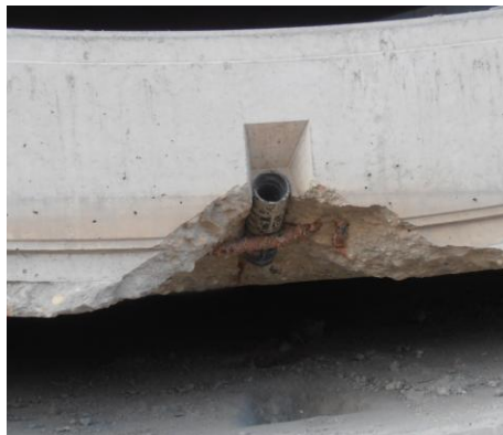
Obr. 5,6.: Porušení segmentu v místech injektážních otvorů
