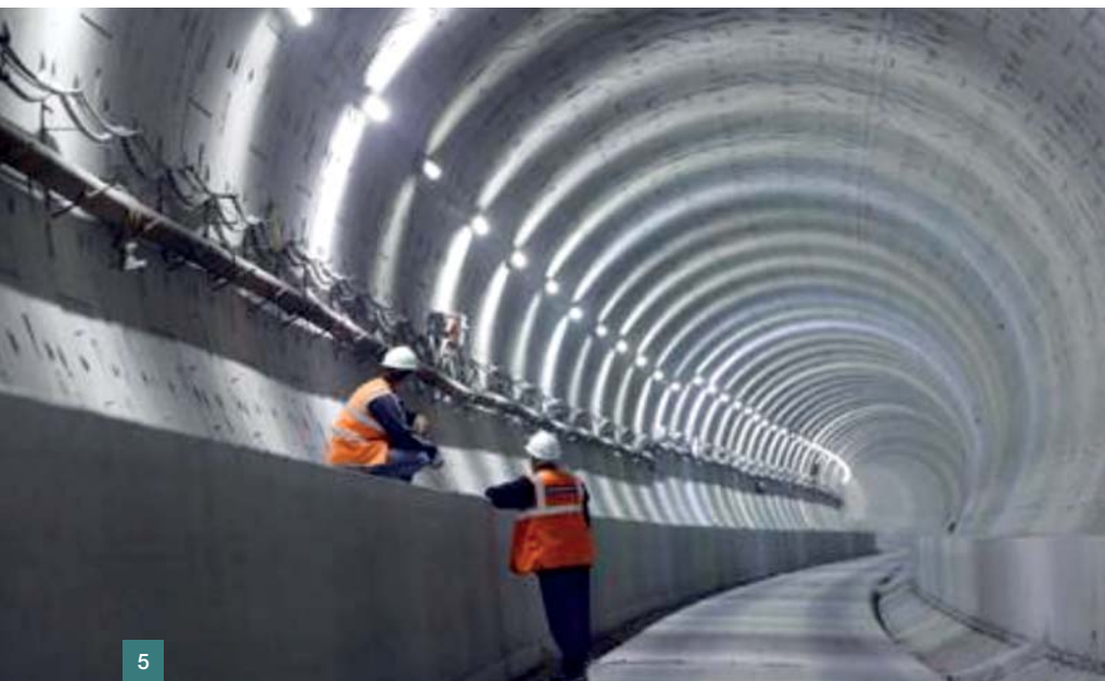
Obr. 5 Šroubované segmentové ostění z drátkobetonu na tunelech CTRL [9]
