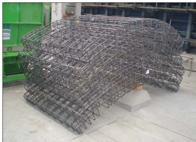
Obr. 7 Ocelové armokoše pro železobetonové segmenty Fig. 7 Steel reinforcement cages for steel bar reinforced concrete segments
