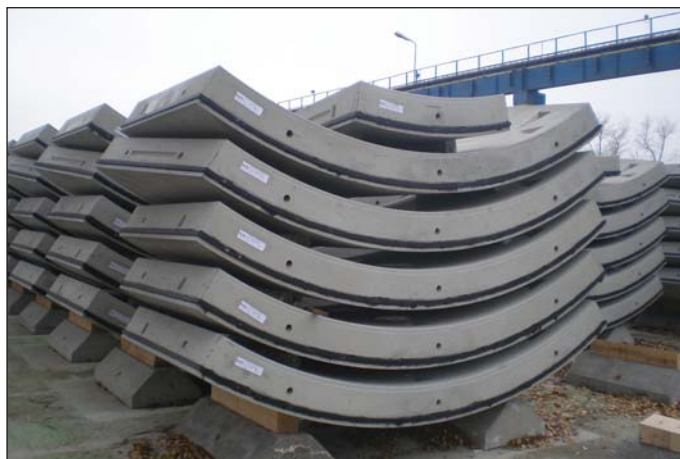
Obr. 3 Skladování prefabrikovaných železobetonových segmentů Fig. 3 Storage of pre-cast steel bar reinforced concrete segments
