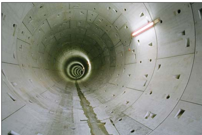
Obr. 1 Ostění tunelu z prefabrikovaných betonových segmentů (Herka, Schepers 2012)
