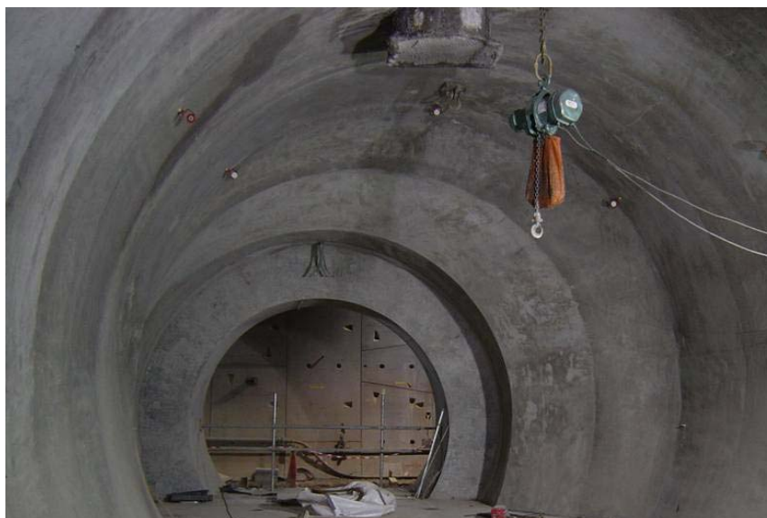
Obr. 6. Dokončující vrstva ze stříkaného betonu Fig. 6. The final layer from sprayed concrete
