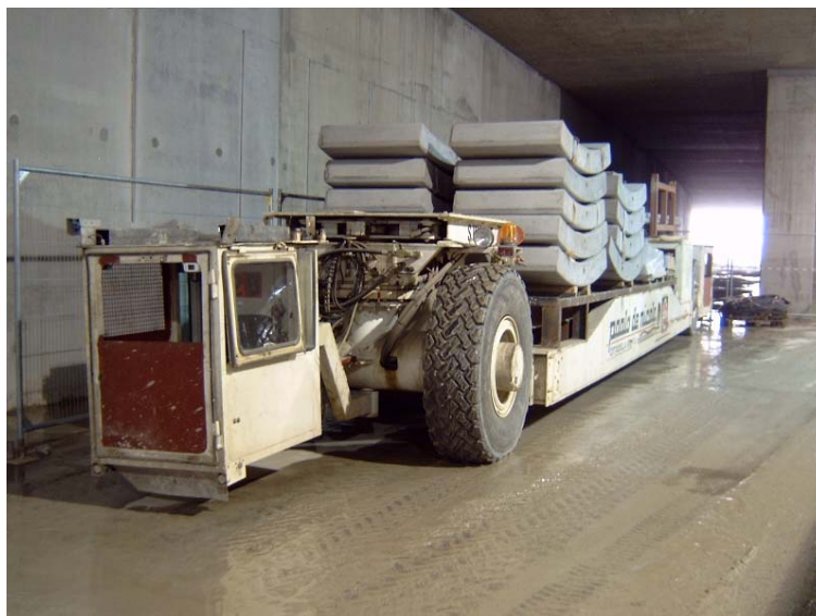
Obr. 3. Přeprava segmentů pro tunel HExEx Fig. 3. Transport of segments in the HExEx tunnel
