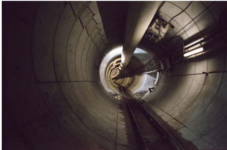
Obr. 2. Tunel PiccEx s rozpíraným segmentovým ostěním z vláknobetonu Fig. 2. The PiccEx tunnel with the expanded SFRC segmental lining
