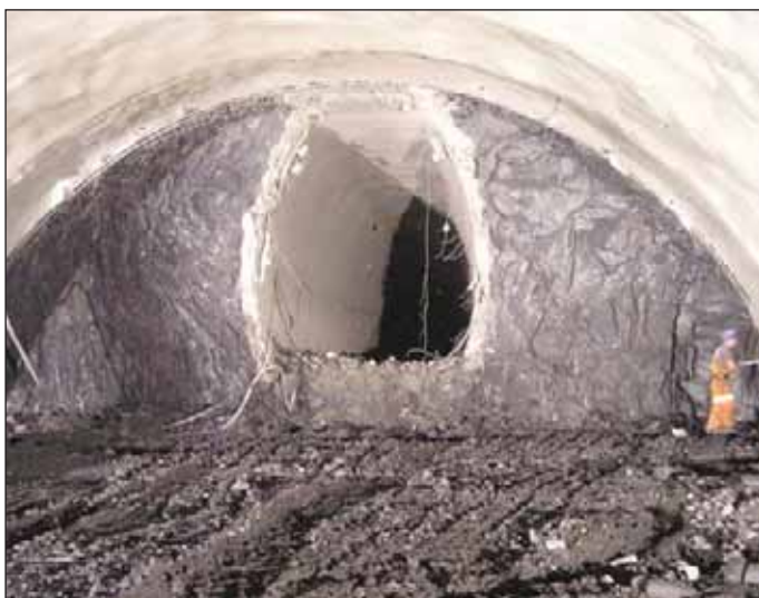
Obr. 3 Průzkumná štola tunelu Komořany Fig. 3 Exploratory gallery for the Komořany tunnel
