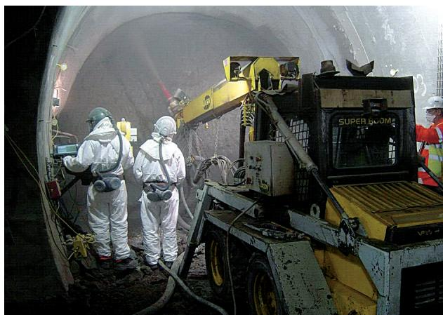
Obr. 7 – Ražba propojek metodou LaserShell
