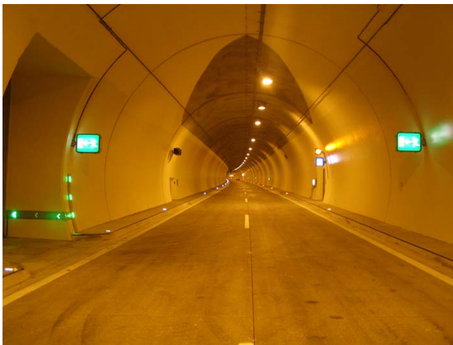
Obr.4 Dokončený silniční tunel Strenger
