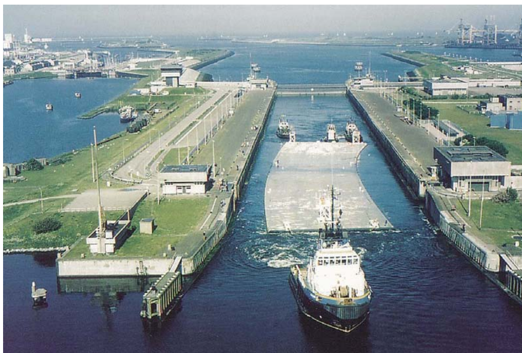
Obr. 3 Plavení tunelového elementu - Piet Hein tunel
