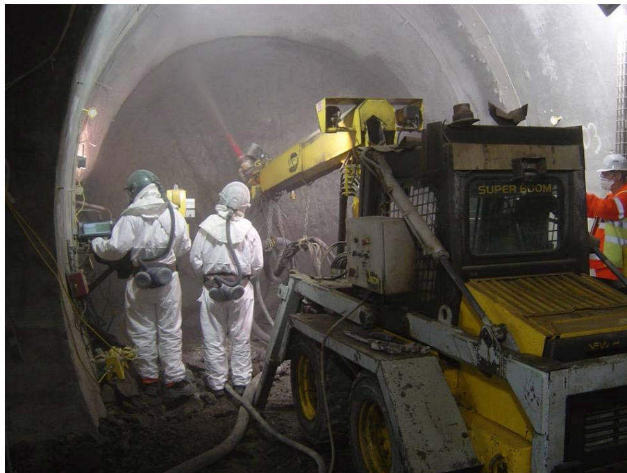
Obr.6 Nástřik betonu na terminálu 5 metodou LaserShell™
