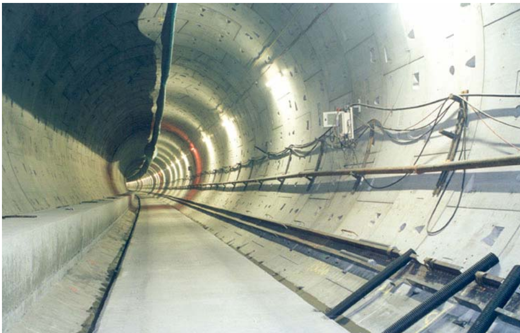
Obr.5 Prefabrikované segmentové ostění tunelů CTRL s polypropylenovými vlákny
