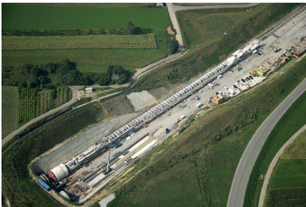
Obr.2 Sestavování TBM před ražbou železničního tunelu Wienerwald
