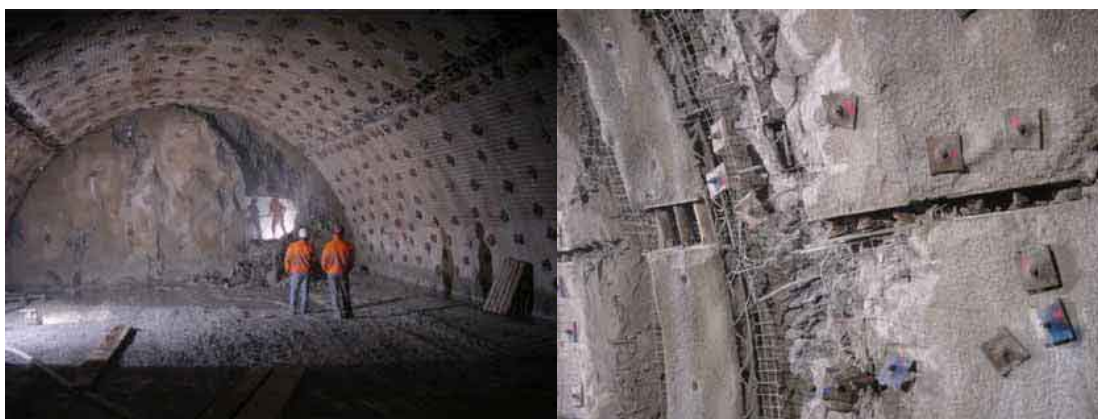
Obr.8 Zajištění výrubu tunelu Strenger proti deformacím
