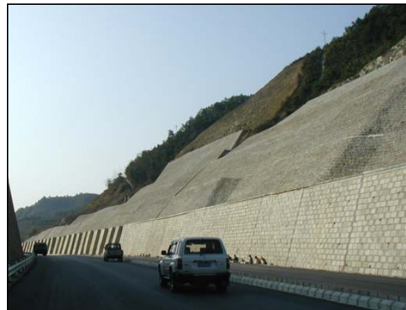
VELKÉ OPĚRNÉ KONSTRUKCE CHRÁNÍCÍ SILNICI
