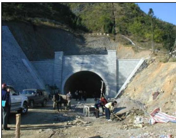
DOKONČENÝ PORTÁL TUNELU
