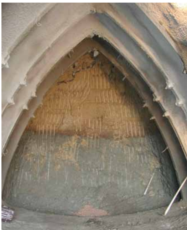
Obr. 2 (a) Průzkumné štoly situované v kalotách tunelů Královo Pole, (b) detail štoly s rozhraním zdravého a zvětralého terciérního jílu /10/. Fig. 2 (a) Exploratory drifts situated in the top headings of the Královo Pole tunnels, (b) detail of the drift with the boundary between weathered and healthy tertiary clay/10/.
