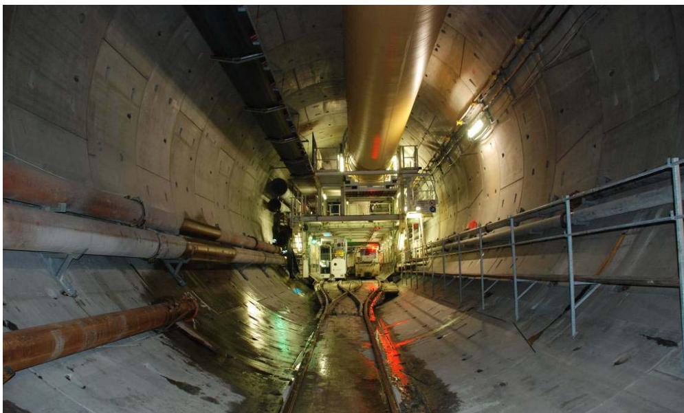
Obr. 2. Segmentové ostění tunelu Hallandsas Fig. 2. Segmental lining of the Hallandsas tunnel
