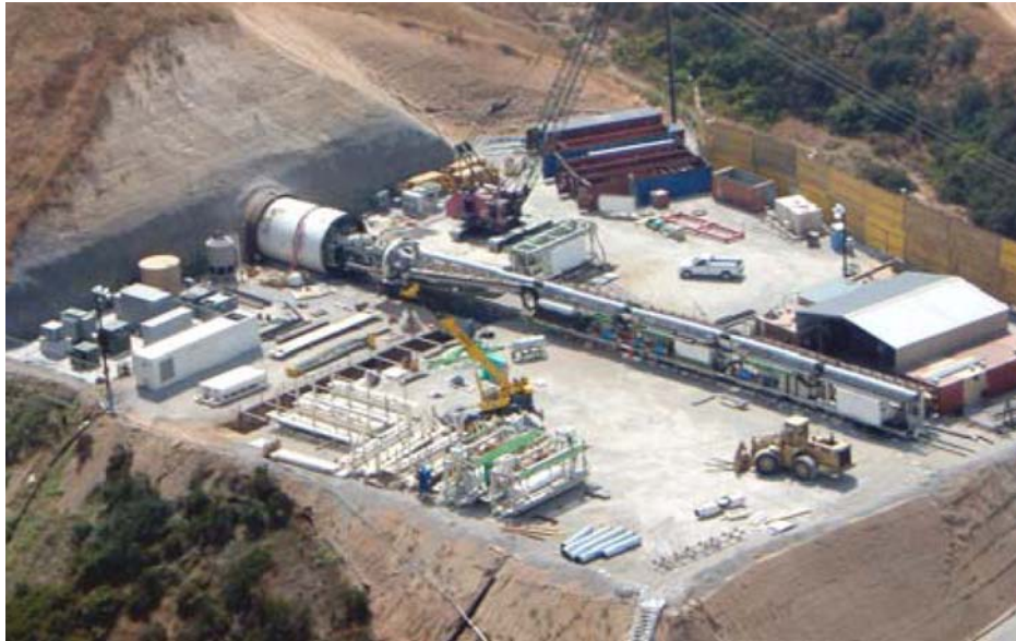
Obr. 4. TBM před ražbou tunelu Arrowhead Fig. 4. TBM prior start of excavation of the Arrowhead tunnel
