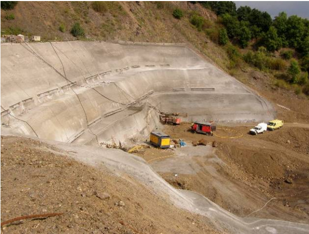
Obrázek 1. Oblast pražského portálu před zahájením ražby
