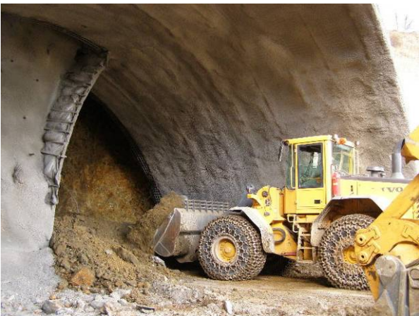
Obrázek 2. Ražba se členěnou kalotou
