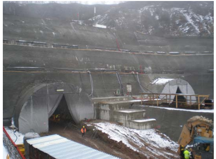
Obrázek 3. Pohled na přitěžovací betonový blok mezi tunely
