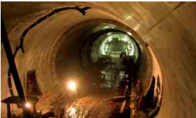
Obr. 3 Betonáž definitivního ostění tunelu Libouchec (šachovnicový způsob)
