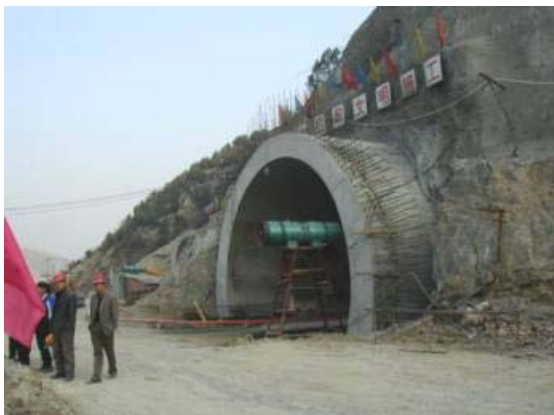
PORTÁL - TUNEL CHANG JIA SHAN
