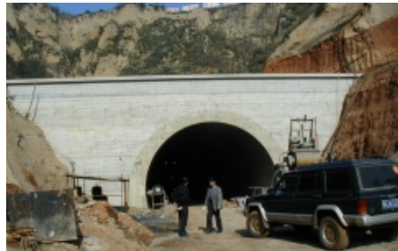
PORTÁL - TUNEL CHEN JIA SHAN
